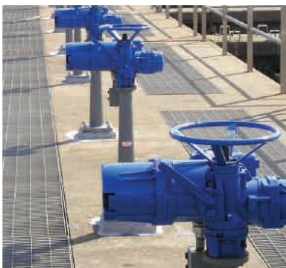
经受-60°C至+70°C温度极限。MX是第一台采用轧制蜗杆和电子控制装置的非侵入式执行器，其中电子控制装置采用表面安装技术进行设计和生产；QX使用了以同样先进的技术制造而成的部件。作为一款真正通过全球认证的装置，QX满足所有有关的欧洲标准，包括ATEX、EMC、机械与噪声，并带有与此类符合性相关的CE标志。
